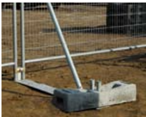
Bodenplatte für Verstrebung
